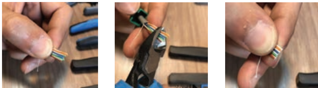
شکل ۲۷- مرتب کردن سیم‌های رنگی مطابق استاندارد
