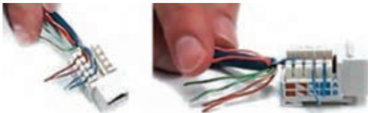
شکل ۳۲- قرار دادن سیم‌های کابل در کیستون
